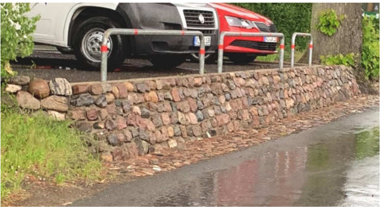
Seestraße Ecke Dorotheenhofer Weg. Die unfallträchtige Abbiegung mit hochgewachsenem Bitumen durch Wurzelwerk der Kreislinde ist vom Gemeindearbeiter Daniel Wachholz und Wolfgang Falk in gelungener Weise hergestellt worden. Parken kann wer will. Die Anwohner müssen sich dort einigen.
