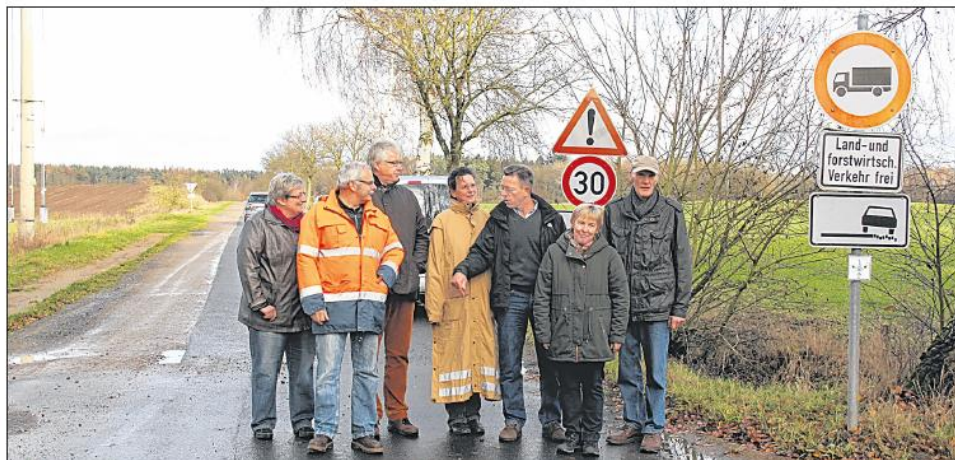
Abnahme der Straßensanierung des Vogtstemmener Weges im Gemeindegebiet Salem. Der nur 3,2 Meter breite asphaltierte Weg mit zwei Metern Bankette (im Bild links) wird ausgiebig von Pendlern sowie in der Erntezeit auch von landwirtschaftlichem Schwerlastverkehr genutzt. Foto: Strunk
